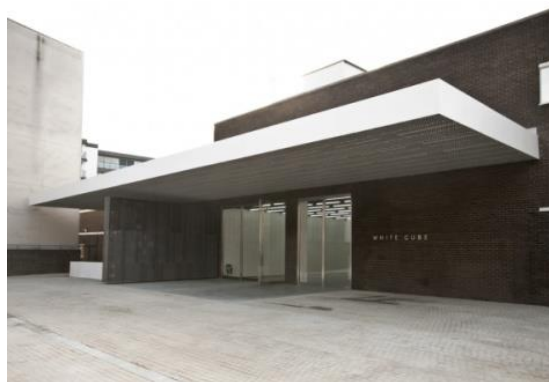
Figura 19 – Fachada da Galeria White Cube, Londres
